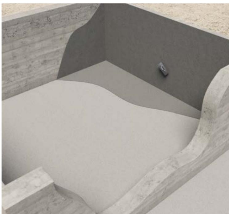
**SE UTILIZA COMO CAPA A LA VISTA PARA LA PROTECCIÓN DEL HORMIGÓN:**
