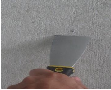
图 3.1.1 使用灰油铲去除基面污渍
