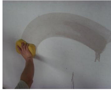
图 3.1.2 使用海绵清理基面
