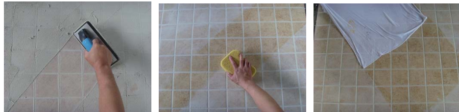
图 10-图 11 填缝剂清洗
