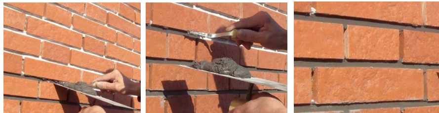
图 7-图 9 喂缝法
