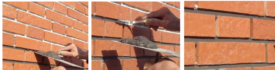
图 7-图 9 喂缝法
