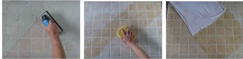
图 10-图 11 填缝剂清洗
