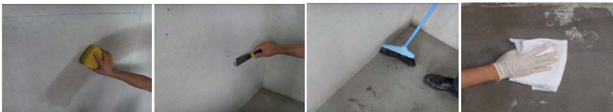
图 1-图 4 基层处理
