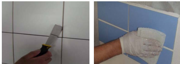
图 15-16 缝隙及表面清洁
