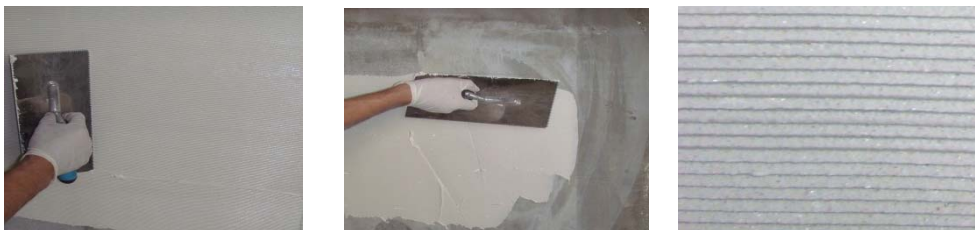
图 9-图 11 胶粘剂施工
