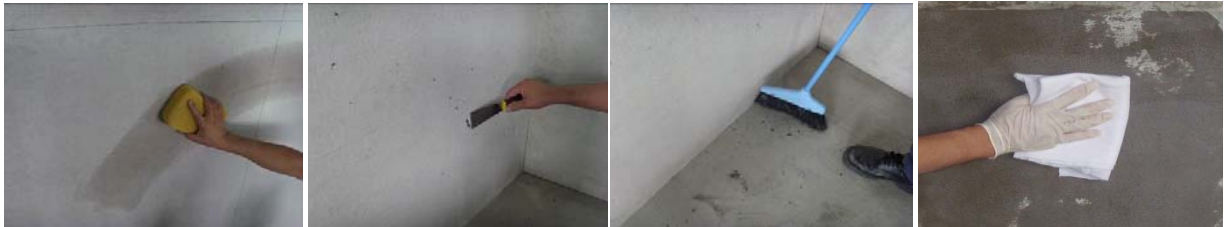
图 1-图 4 基层处理
