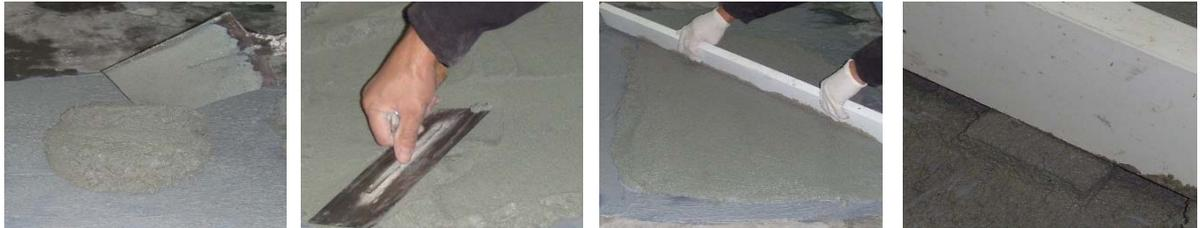
图9-图12 找平施工
