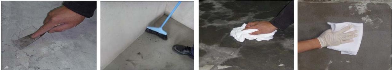
图 1-图 4 基层处理
