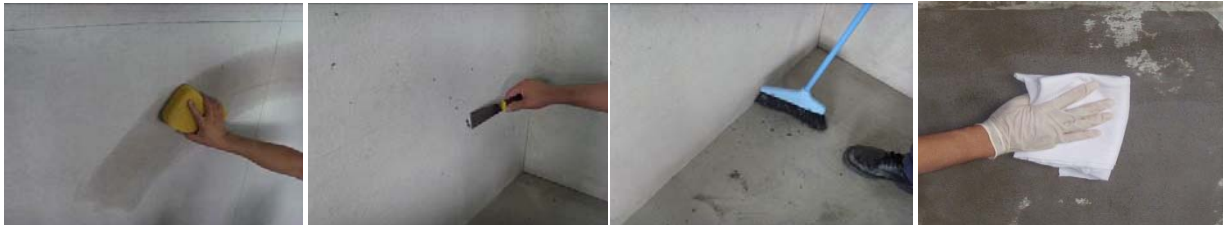
图 1-图 4 基层处理
