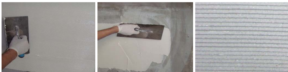
图 9-图 11 胶粘剂施工
