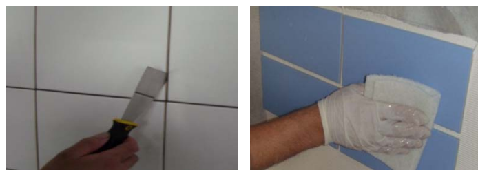
图 15-16 缝隙及表面清洁
