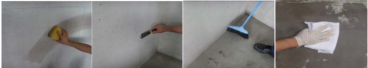
图 1-图 4 基层处理
