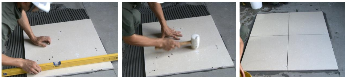
图 13-图 15 人造石安装
