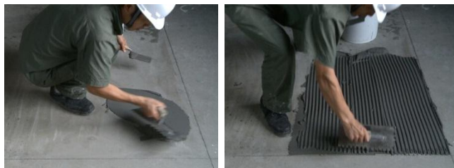
图 9-图 10 胶粘剂施工
