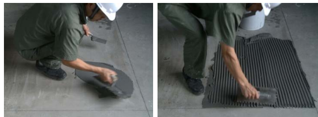
图 9-图 10 胶粘剂施工
