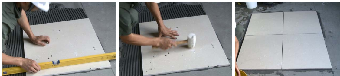
图 13-图 15 人造石安装
