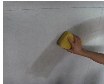
图 3.1.4 使用海绵擦除表面明水
