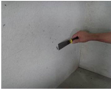
图 3.1.1 使用铲刀去除基面污渍
