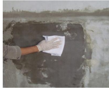
图 3.1.2 使用抹布清理基面
