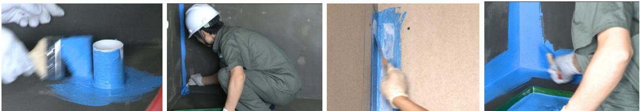
图 3-图 6 细部节点处理
