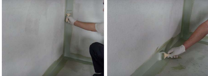
图 3-图 4 墙地面过渡处预处理
