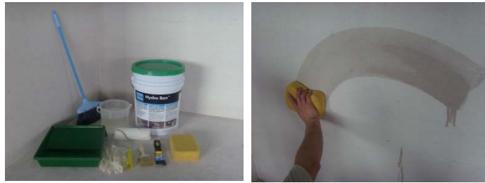
图 1-图 2 基面处理
