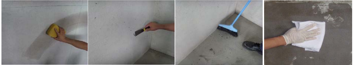
图 1-图 4 基层处理
