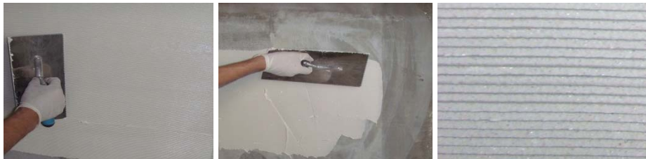
图 9-图 11 胶粘剂施工
