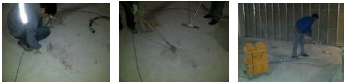
图 1~图 3：基层处理
