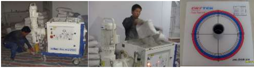
图 8~图 10：泵送施工前的准备工作
