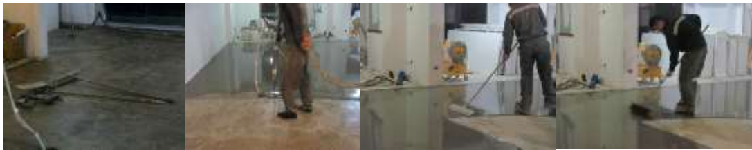
图 11~图 14：泵送施工
