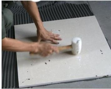
图 3.7.2 橡皮锤辅助施工
